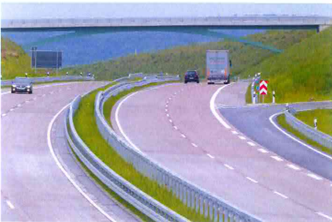
Blickrichtung Süden auf Wirtschaftswegbrücke
