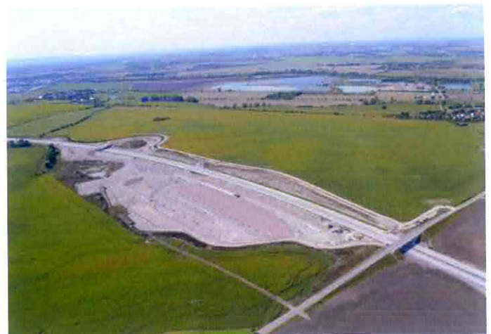
Im Bau befindliche Tank- und Rastanlage „Leubinger Fürstenhügel“ © DEGES, Luftbildvertrieb Müller
