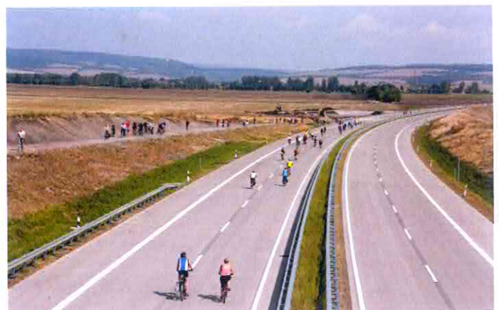
Radler bei der „Tour de Frömmshcht“ am 15. August 2015 auf der fast fertigen A 71 © Ralf Nicolai
