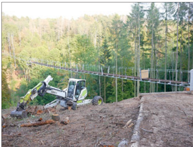
Die Brücke ist bereits klar zu erkennen Fotos: Robin Kendon / IPU
